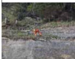
Ein Sicherheitsholzschlag verlangt immer auch von unseren Mitarbeitern höchste Konzentration und perfekte Arbeit. So mussten bei diesem Auftrag unsere Forstleute am hängenden Seil die Felswand reinigen, Bäume bis zur Hangkante fällen, das Schutznetz kontrollieren und neu instand stellen. Die schwierigsten Bäume mussten schliesslich mit dem Heli stückweise ausgeflogen werden.
